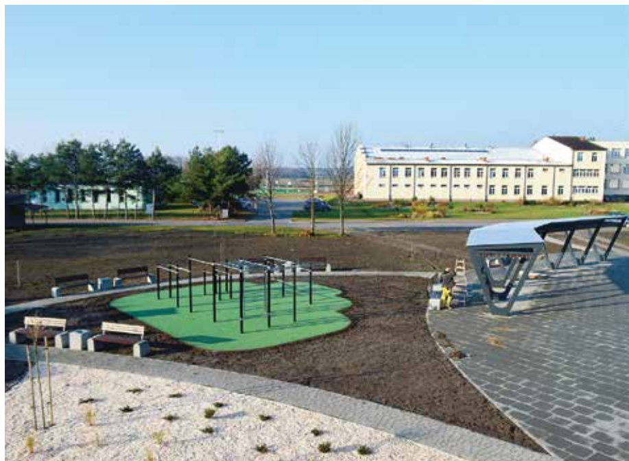
W ramach inwestycji zagospodarowany został także teren wokół obiektu, gdzie posadzono zieleni oraz zamontowano ławeczki i wiaty
