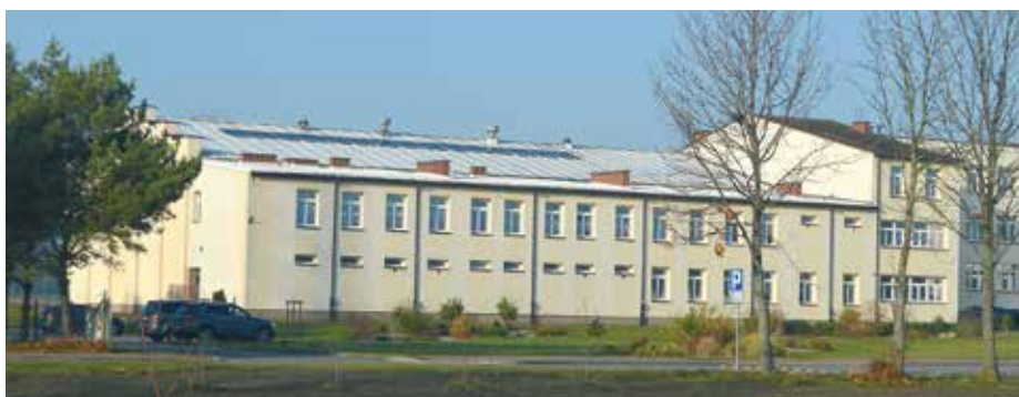
Budynek ZPO w Piszczacu ma już zamontowaną fotowoltaikę
