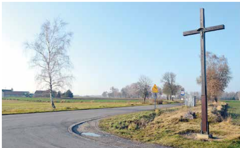
W ramach Polskiego Ładu wyremontowana zostanie droga powiatowa nr 1068L
