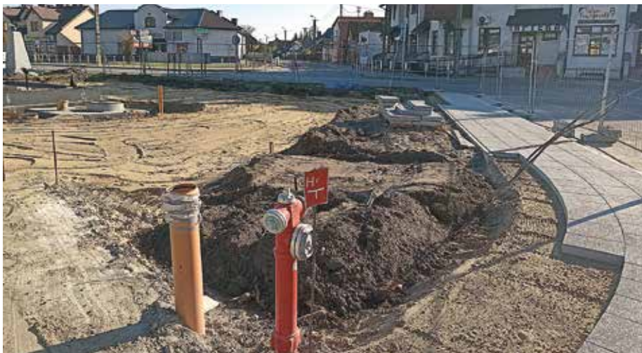
W listopadzie rozpoczęło się m.in. układanie kostki brukowej
