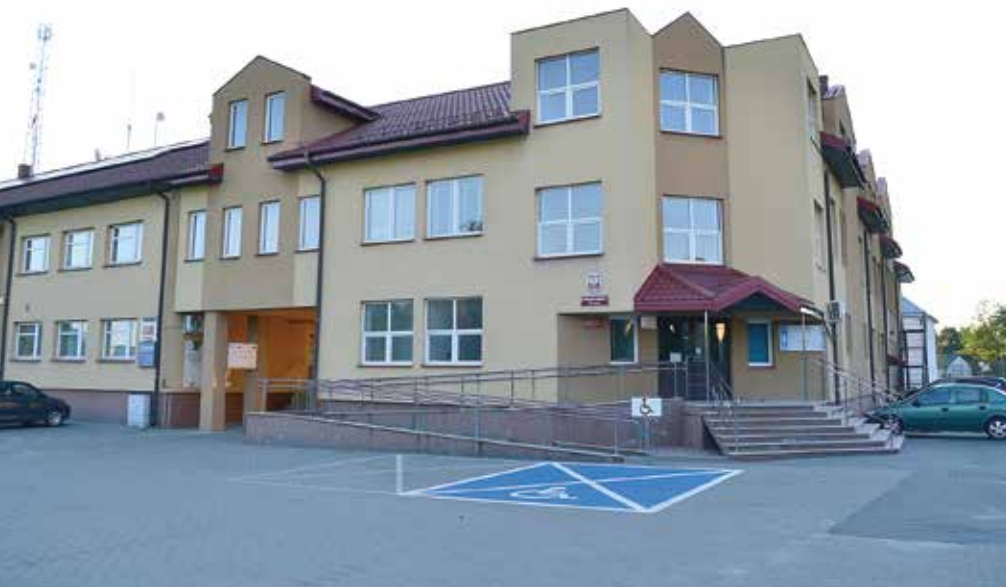
W budynku Urzędu Gminy wymienione zostało oświetlenie
