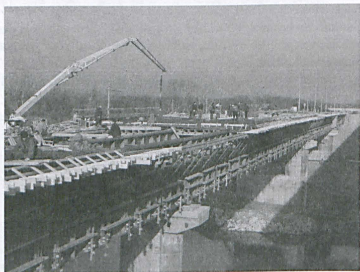
Budowa mostu w Kukurykach
