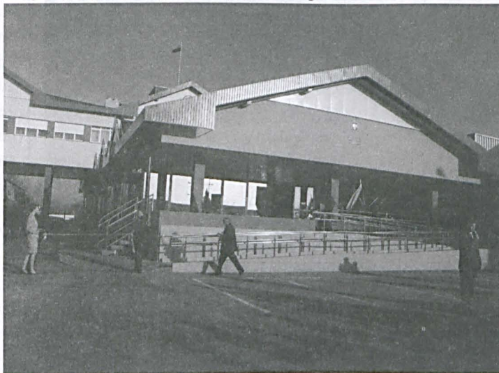
Zmodernizowane przejście samochodowe w Terespolu fot. Danuta Wowczeniuk
