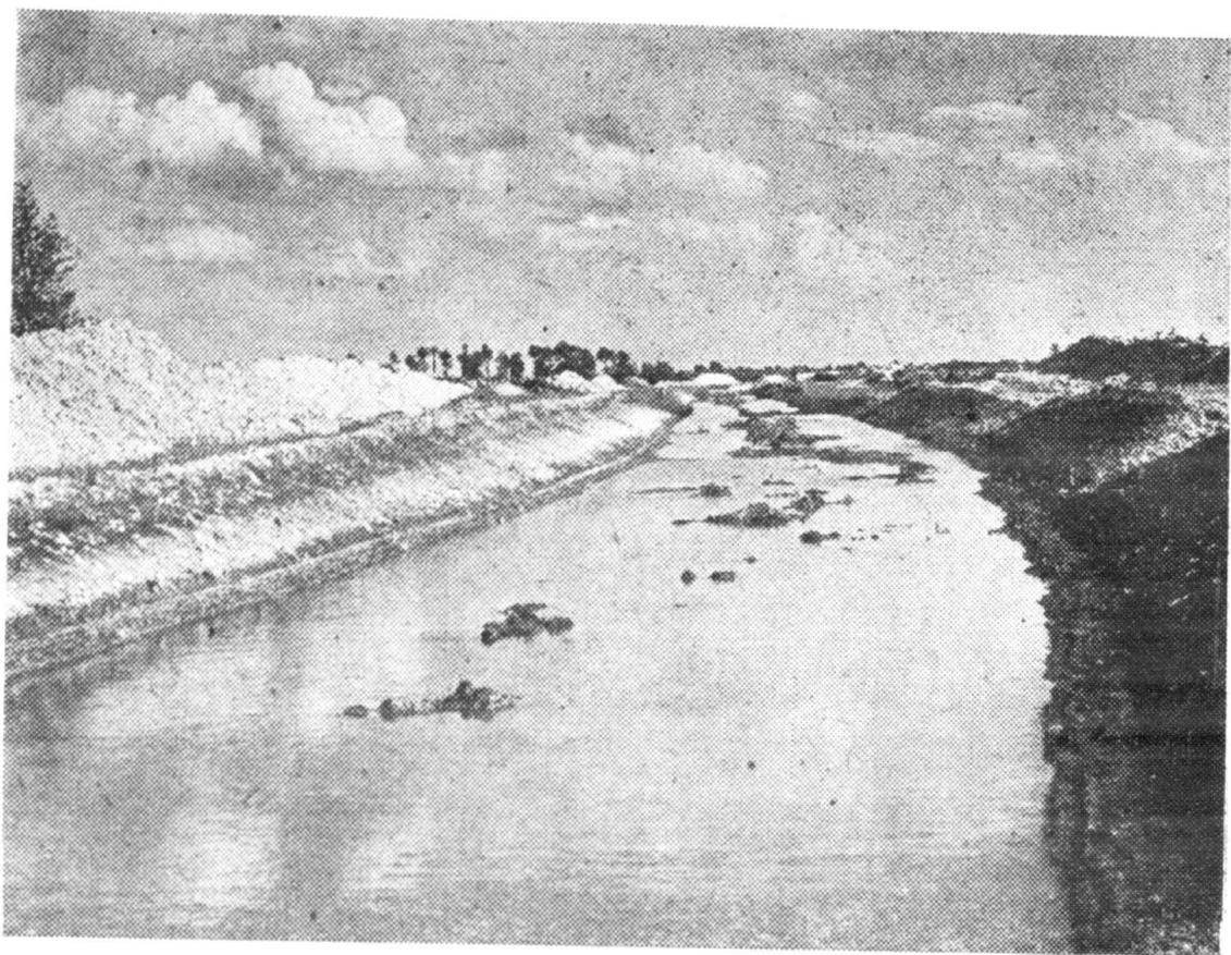
Rys. 12. Kanał w stanie surowym
