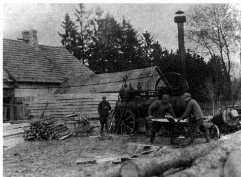
Fot. 15. Lokomobila – maszyna napędzająca tartak znajdujący się w zabudowaniach folwarcznych. Na zdjęciu z lewej strony mechanik Tomasz Bronikowski, lata 30. XX w. Fotografia z Kroniki Szkoły Podstawowej w Jabłoni.
