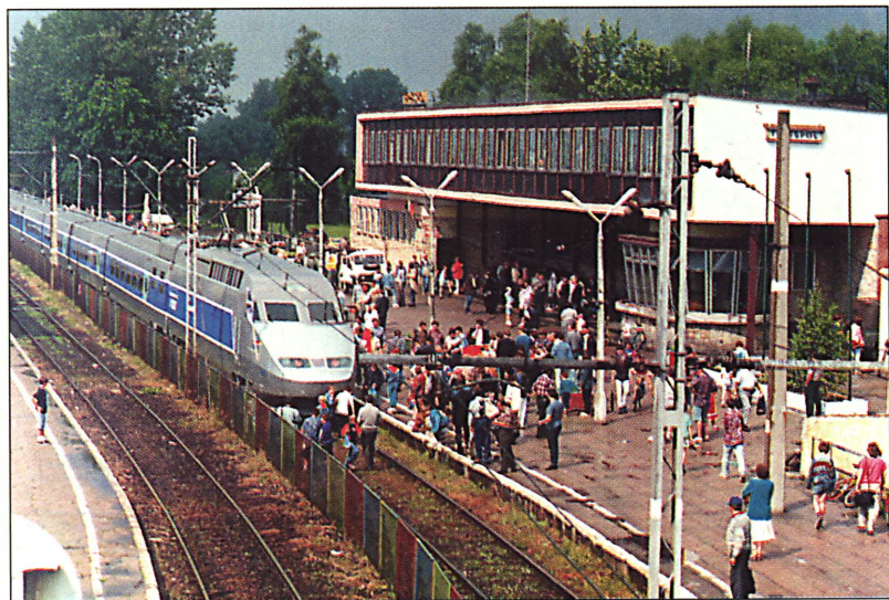
Dworzec kolejowy z roku 1964
