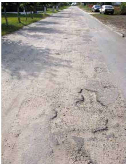
Widoczne na zdjęciu spękania i ubytki drogi w Starym Pawłowie to już przeszłość
