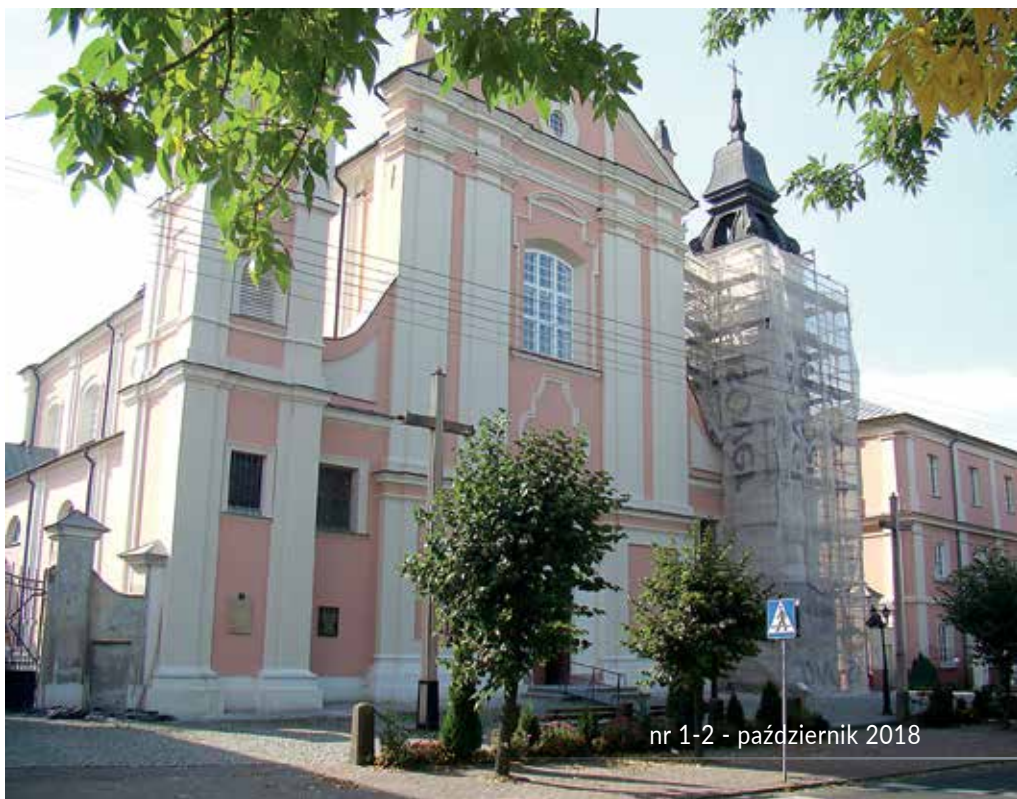
Gmina dba też o zabytki. Pomogła m.in. przy remoncie kościoła pw. Trójcy Świętej, szykującego się na jubileusz 200-lecia diecezji
