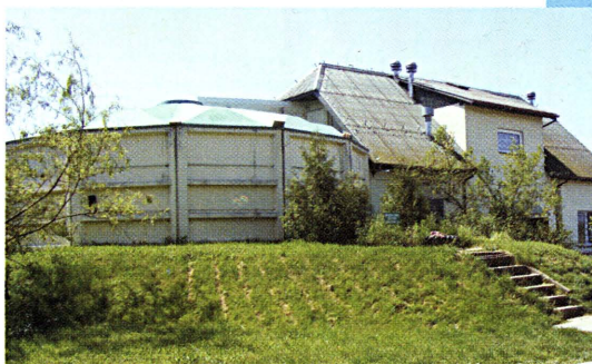
Oczyszczalnia ścieków w Piszczacu
