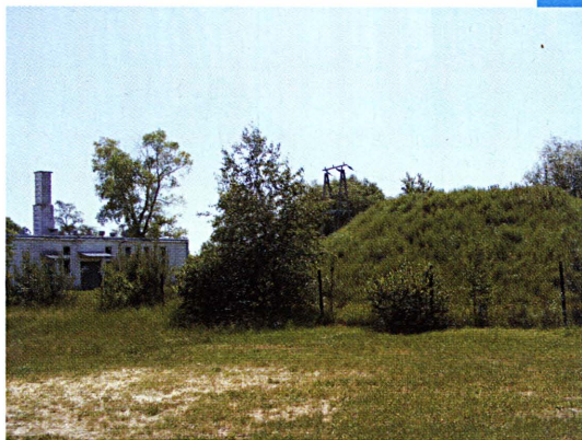
Ujęcie wody w Piszczacu
