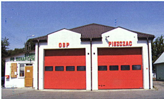
Remiza strażacka w Piszczacu
