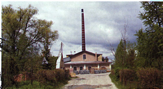
Cegielnia RSP w Chotyłowie
