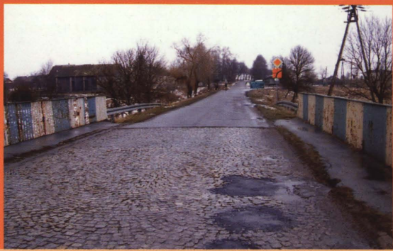
Stan nawierzchni na moście
