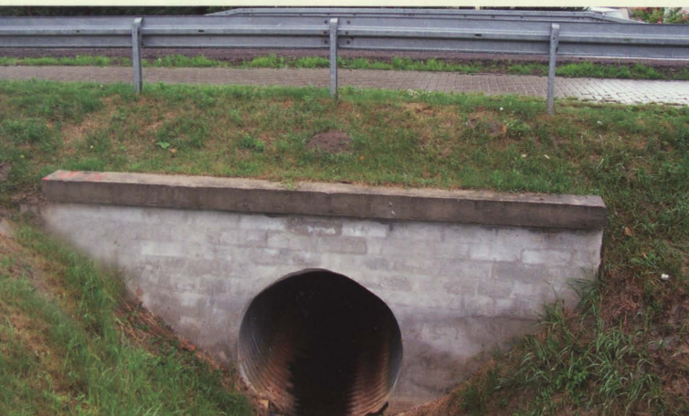
Przepust w Kobylanach
