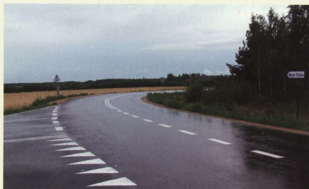
Droga Kobylany - Zastawek. Włączenie do drogi do Bazy Paliw OLPP
