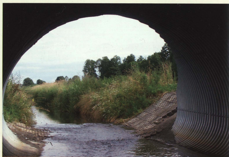
Rzeka Czapelka i przepust w Zastawku
