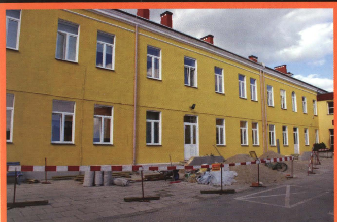
Trwa remont dachu i elewacji szkoły.
