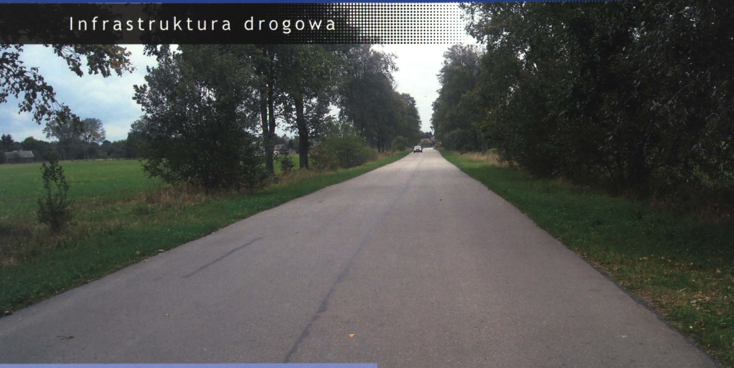
Droga powiatowa Krzywówółka - Sławatycze po remoncie
