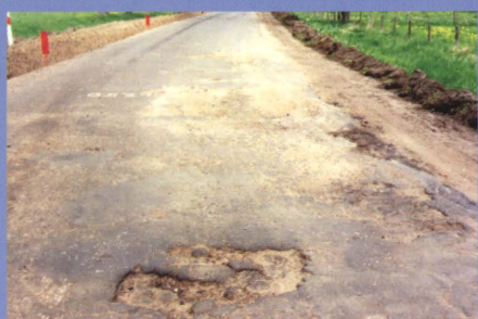
Droga Zalesie - Sławatycze - początek robót
