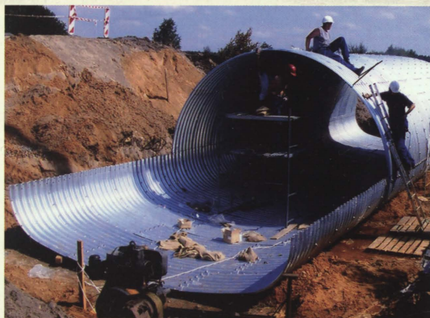
Przebudowa przepustu w Zastawku
