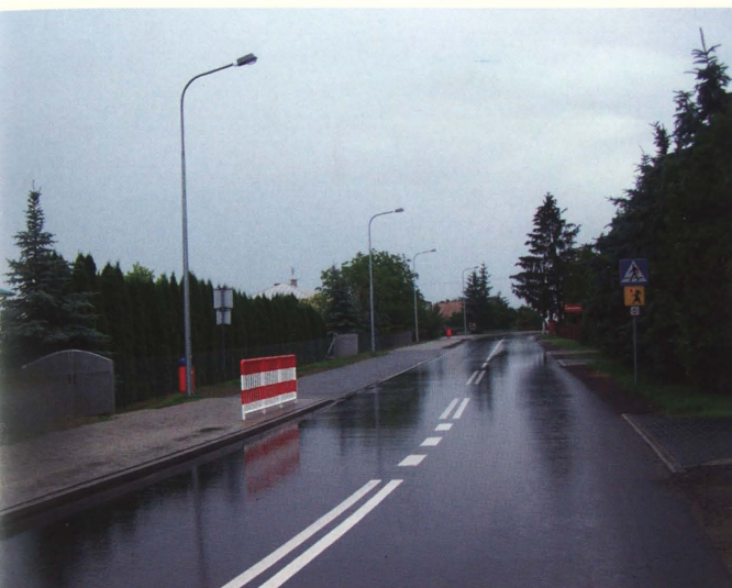
Droga powiatowa w Kobylanach
