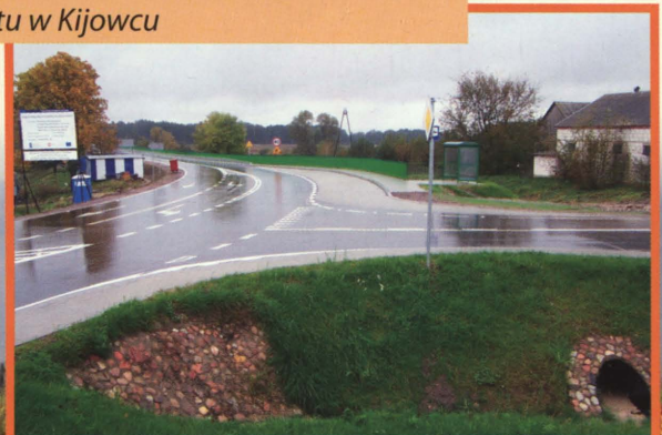
Skrzyżowanie w Kijowcu z widokiem na nowy most
