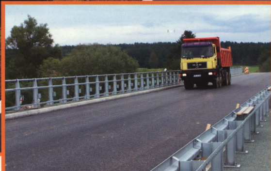
Próba obciążenia na moście w Kijowcu
