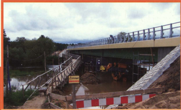
Budowa mostu w Kijowcu
