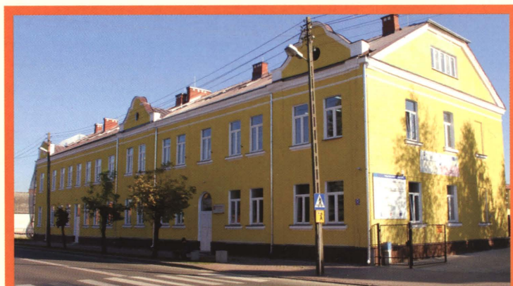
Budynek liceum w trakcie realizacji projektu.
