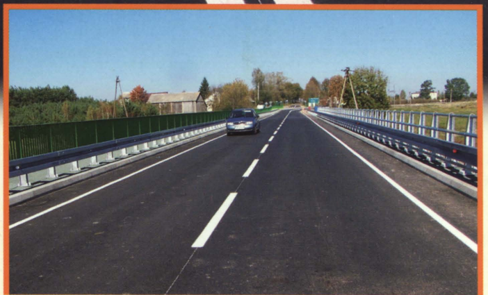
Przejazd nowym mostem
