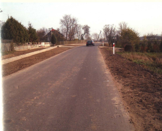
Droga w Dereczance po przebudowie
