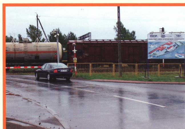
Przejazd kolejowy na drodze powiatowej w Kobylanach
