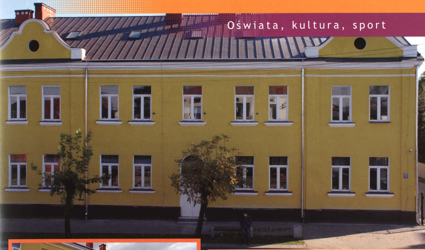
Nowa elewacja budynku Liceum Ogólnokształcącego w Międzyrzeczu Podlaskim
