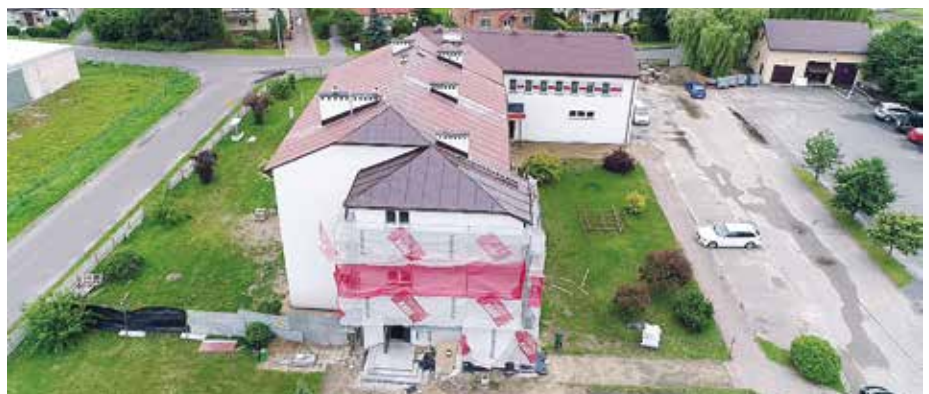
W latach 2019-2021 przeprowadzona została termomodernizacja budynków użyteczności publicznej, m.in. Urzędu Gminy i Zespołu Placówek Oświatowych
