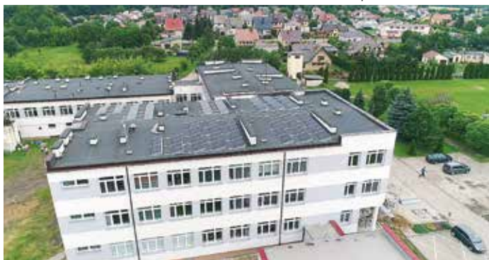
Gmina daje dobry przykład, jak troszczyć się o środowisko: na zdjęciu panele fotowoltaiczne na dachu Szkoły Podstawowej
