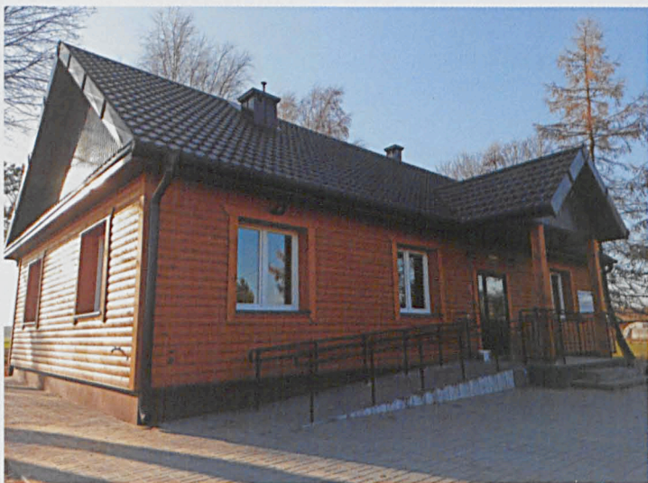
Świetlica w Żukach po modernizacji
