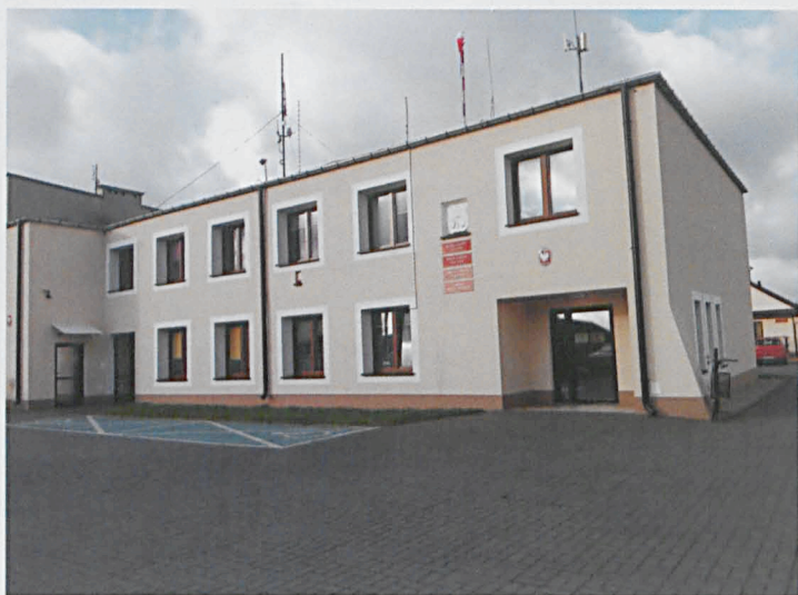
Urząd Gminy po termomodernizacji
