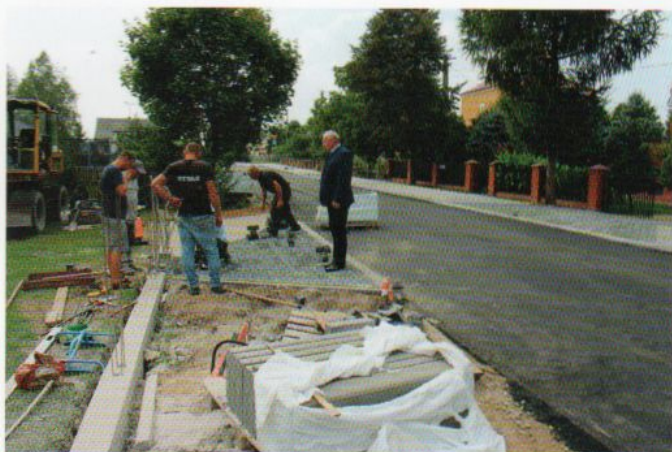
Budowa ul. Ogrodowej
