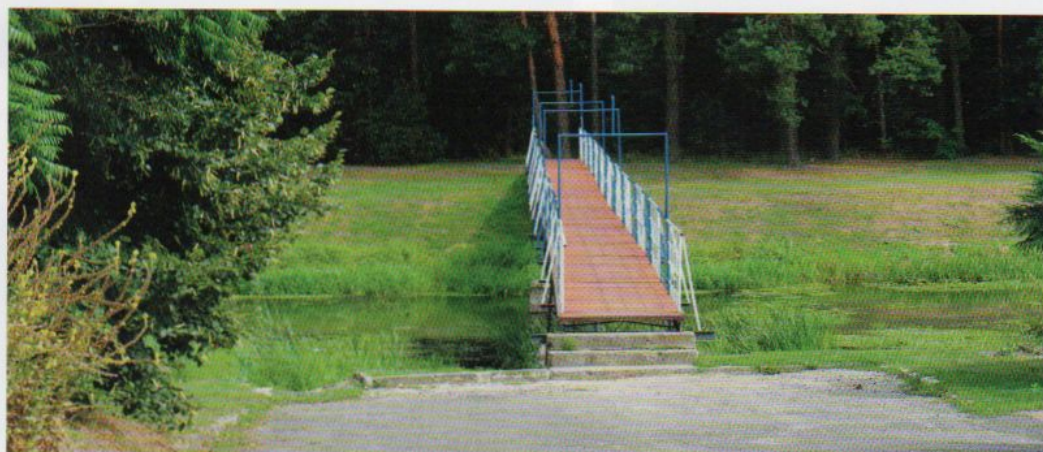
Wyremontowana kładka przez Zalew
