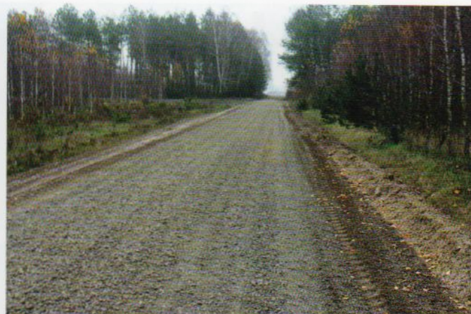
Utwardzona droga Kopytów-Kolonia – Zastawek (4 km)
