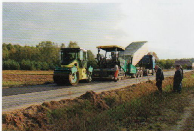
Budowa drogi w Elżbiecinie
