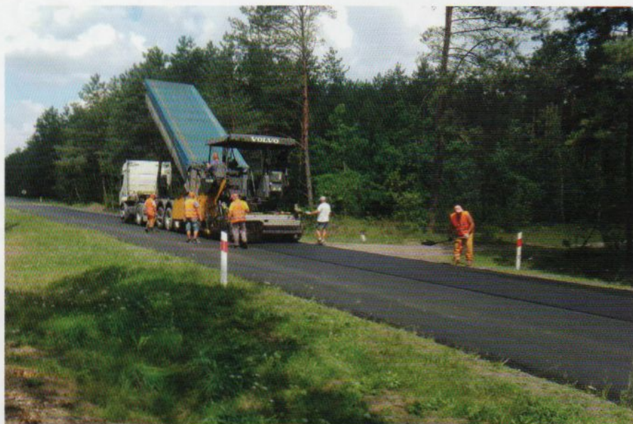
Remont drogi wojewódzkiej Kodeń - Zalesze
