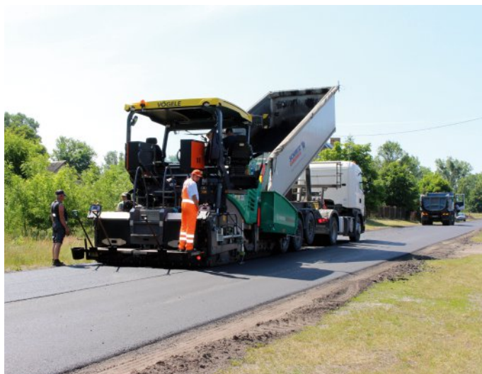
Remont DW 816 - Dobratycze (lipiec 2021 r.)
