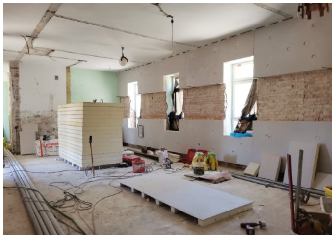
Termomodernizacja budynku po byłym przedszkolu (czerwiec 2021 r.)
