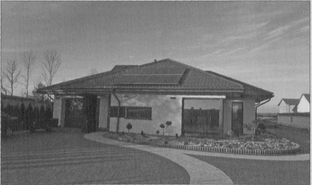
Instalacje OZE na budynku mieszkalnym
