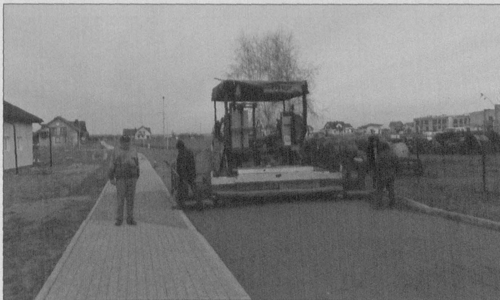
Budowa ulicy Sportowej w Konstanczynie.
