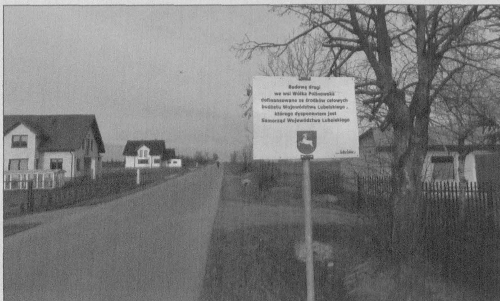
Wykonany odcinek drogi w Wólce Polinowskiej.
