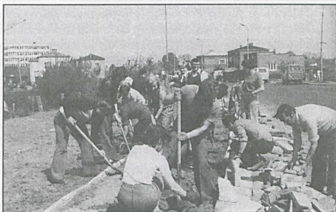
Budowa chodnika przy Alei Tysiąclecia, gdzie wcześniej były wykopy po zakładaniu sieci wod.-kan. Biała Podlaska 21 maja 1978 r. Fot. H. Bojanowski, KAW, [w:] MBP BP
