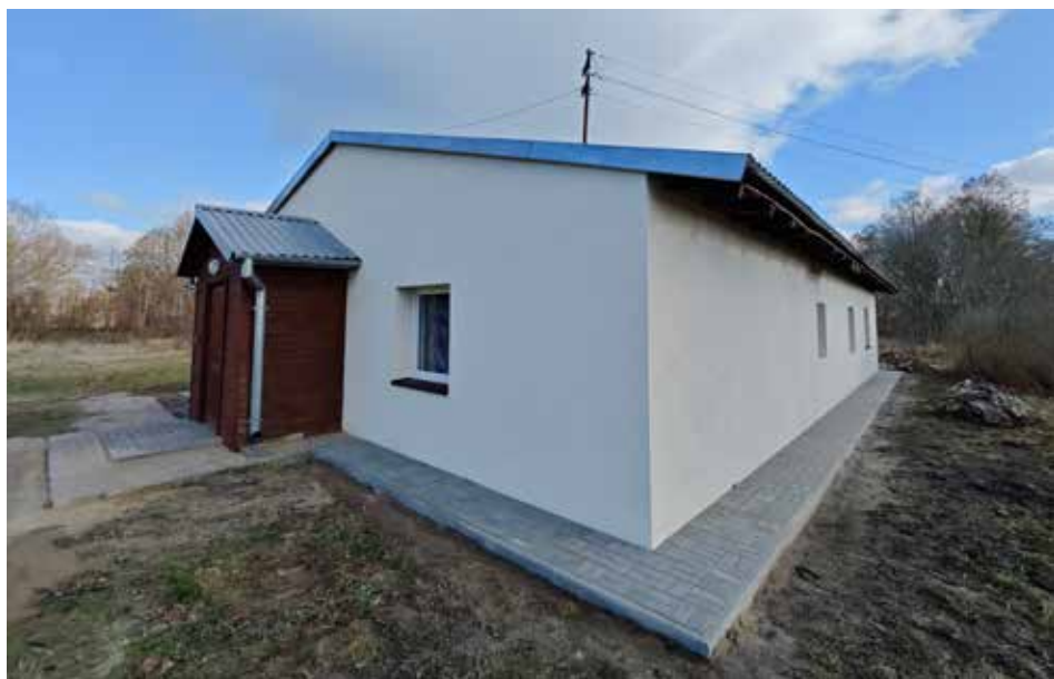
Remont świetlicy w Nowosiólkach
