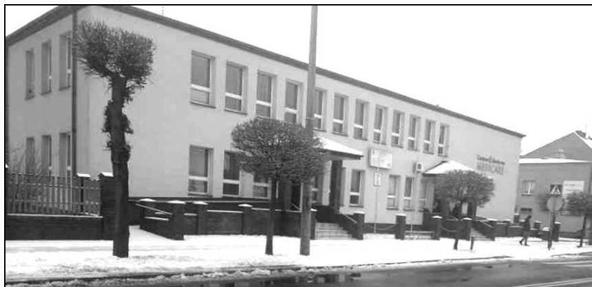
Przychodnia w Parczewie, ul. 11 Listopada 48. W latach 1951-2001 Poradnia Przeciwgruźlicza zajmowała parter budynku. Fot. Bogumiła Paszkowska-Bloch
