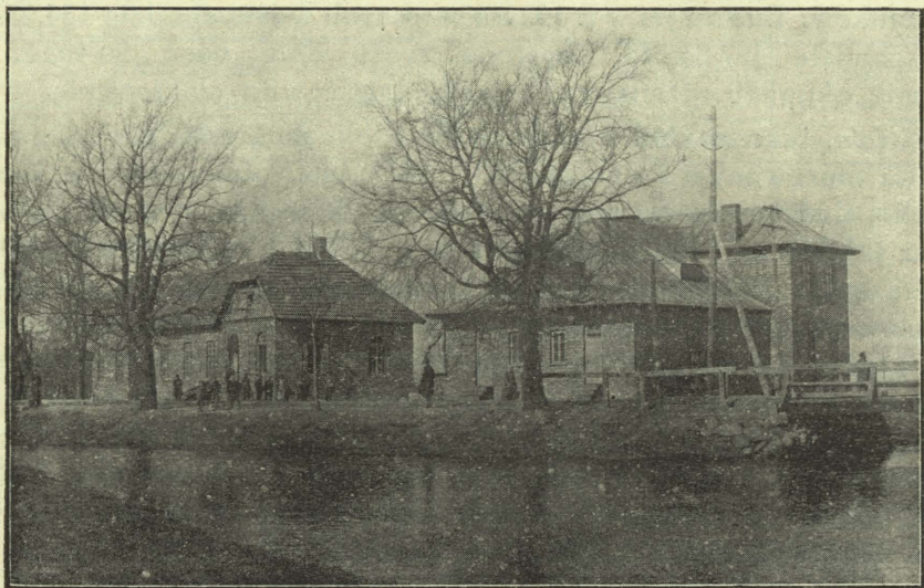
ELEKTROWNIA I ŁAŹNIA
