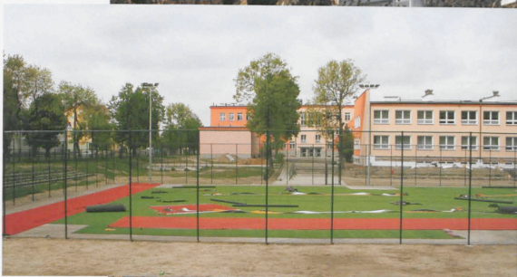
Szkola Podstawowa Nr 5 - budowa boiska wielofunkcyjnego
