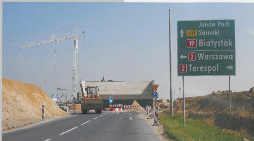
Przebudowa białostkiej obwodnicy
