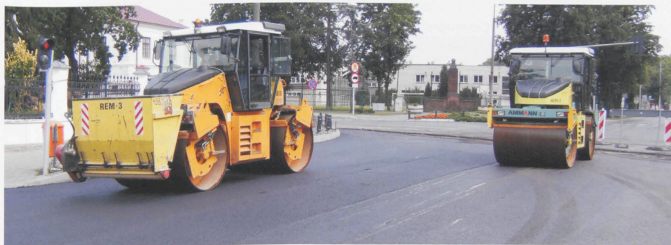
Budowa ulicy Zamkowej
