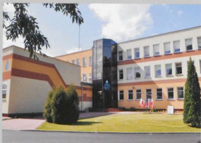
Siedziba BWiK "WOD-KAN" po modernizacji
