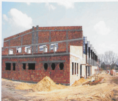
Szkola Podstawowa Nr 3 - budowa hali sportowo-widowiskowej
