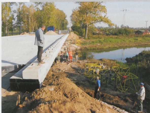
Most na rzece Krznie - w trakcie modernizacji
