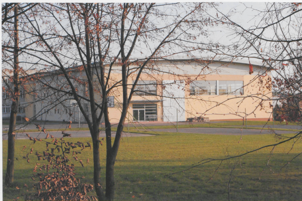
Sala sportowo-widowiskowa przy ulicy Akademickiej
