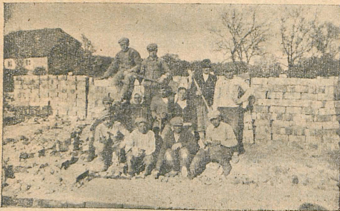
Praca przy budowie U. L. w Woskzrenicach już rozpoczęta. Powyższe zdjęcie p. St. Danielaka ilustruje te prace.
