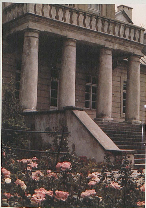
Dwór w Romanowie po odbudowie w latach 1959-1962. Muzeum Józefa Ignacego Kraszewskiego.
