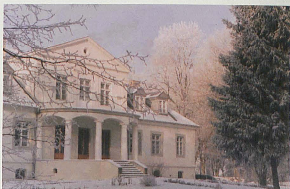
Dwór od strony parku, z odbudowanym balkonem.
