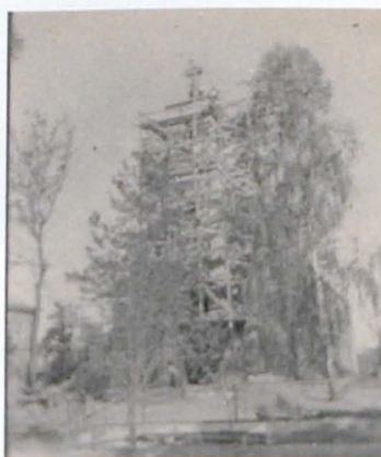
Rusztowania przy wieży kościoła 1958 r.
