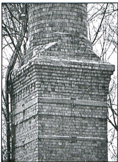
Fragment komina Fabryki Raabego, fot. 2011 r.
