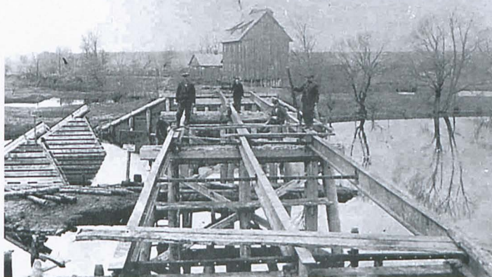
Biała Podlaska, budowa mostu na Krznie 1919 r.
