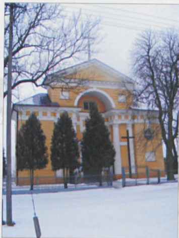
Kościół parafialny pw. Narodzenia Najświętszej Marii Panny w Motwicy, pierwotnie cerkiew unicka zbudowana w latach 1796-98 r.
