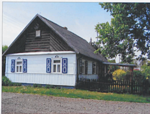
Przykład budownictwa drewnianego na terenie gminy Wisznice.
