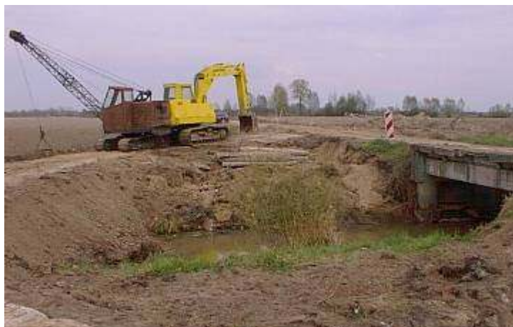
Objazd na czas przebudowy mostu na drodze Kobyłany-Lebiedziew
