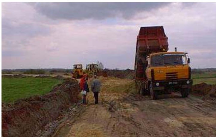
Roboty ziemne (warstwa odsączająca) – Kobyłany-Lebiedziew
