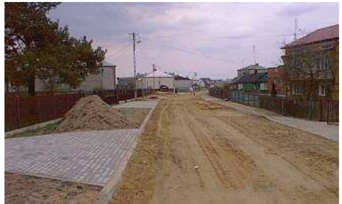
Budowa zjazdów do posesji na ul. Słonecznej w Małaszewiczach
