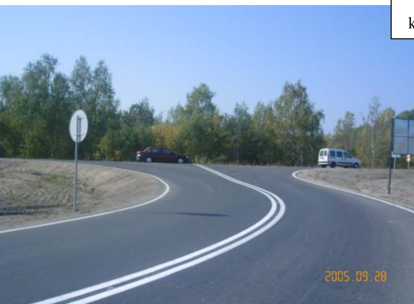
Początek nowej drogi Kobylany-Lebiedziew km. 0+000
