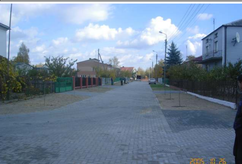
ul. Cicha – po zakończeniu robót drogowych
