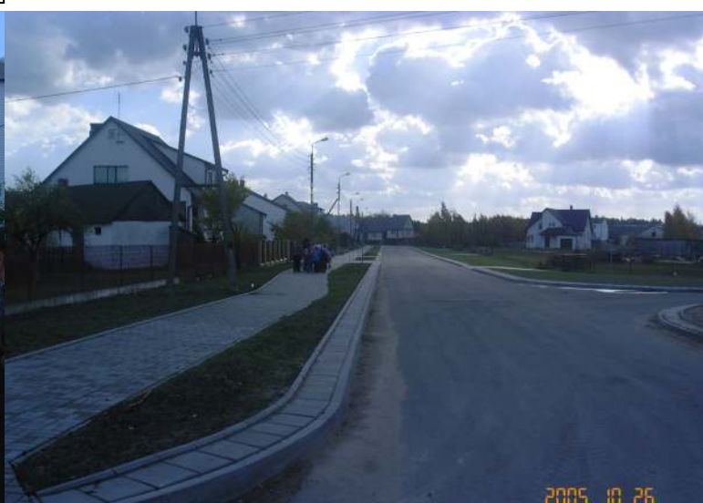
ul. Wiejska - po zakończeniu robót drogowych
