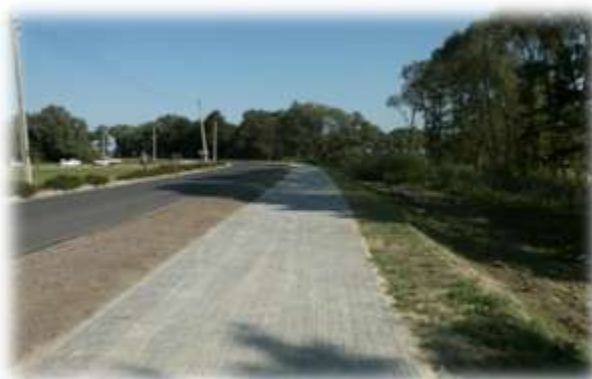
Ścieżka rowerowa w Kobylanach
