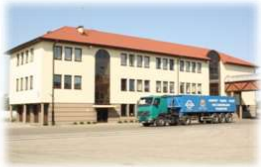
Terminal fitosanitarny w Kobylanach
