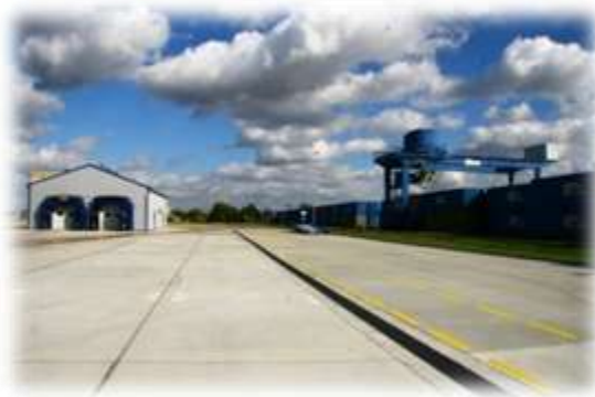
Centrum Logistyczne PKP CARGO w Małaszewiczach
