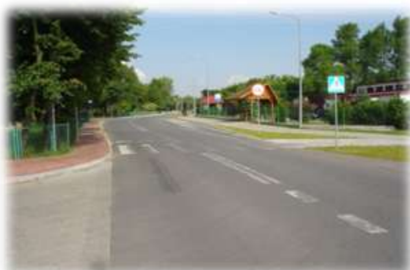
Ulica Piłsudskiego w Koroszczynie – droga powiatowa po modernizacji
