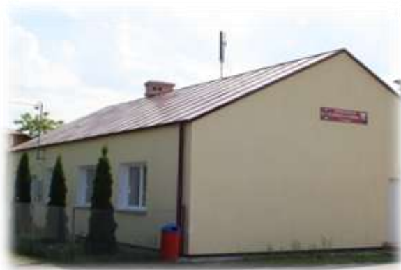
Remizo świetlica w Łęgach
