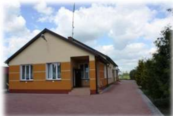
Świetlica wiejska w Małaszewiczach Małych
