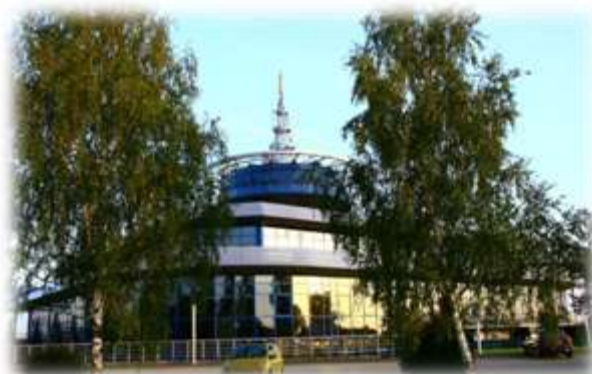
Terminal Samochodowy w Koroszczynie
