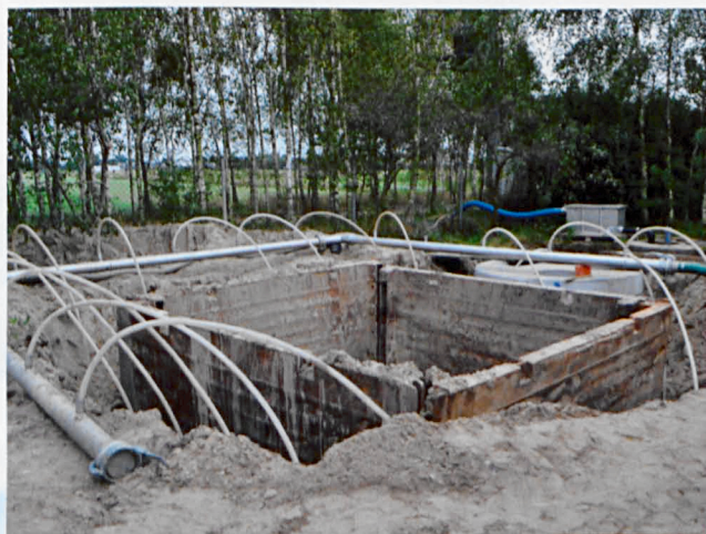
Rozbudowa oczyszczalni ścieków w Piszczacu
