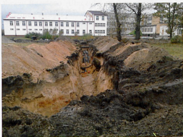
Budowa sieci c.o. do budynków Urzędu Gminy
