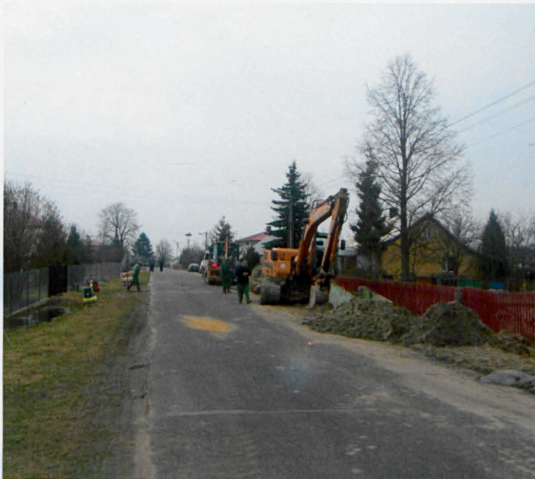
Zahorów - budowa sieci kanalizacyjnej
