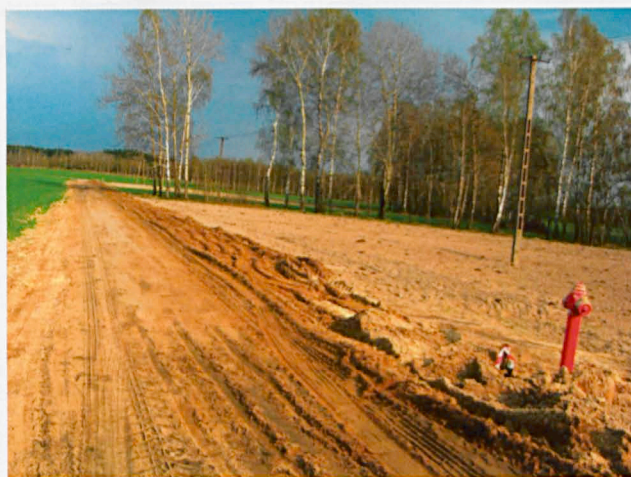
Budowa sieci wodociągowej Kolonia III Piszczac
