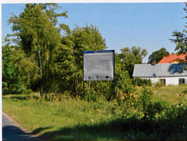
Budowa sieci kanalizacyjnej w Chotyłowic
