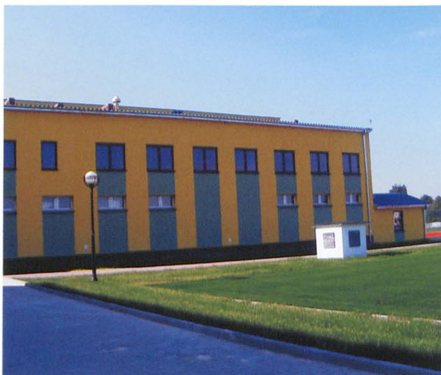
Nadbudowa zaplecza sali gimnastycznej, powstało trzy pomieszczenia dydaktyczne, pomieszczenie magazynowe, klatka schodowa z odrębnym wejściem oraz toalety.
