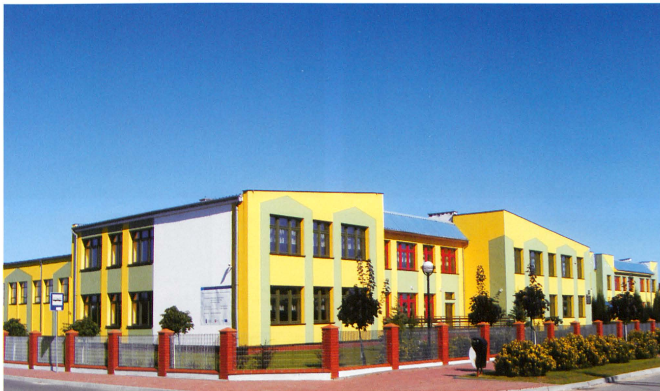
Wykonano termomodernizację budynku szkolnego, która przyczyni się do zaoszczędzenia energii cieplnej
