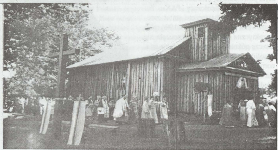
Cerkiew neounicka w Kostomłotach. Jedna z pierwszych prac konserwatorskich wykonanych przez ludzi związanych z Fundacją Ochrony Zabytków.
