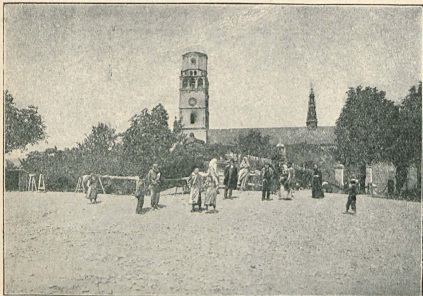
Część wieży po odpadnięciu wierzchołka i filarów drewnianych.
