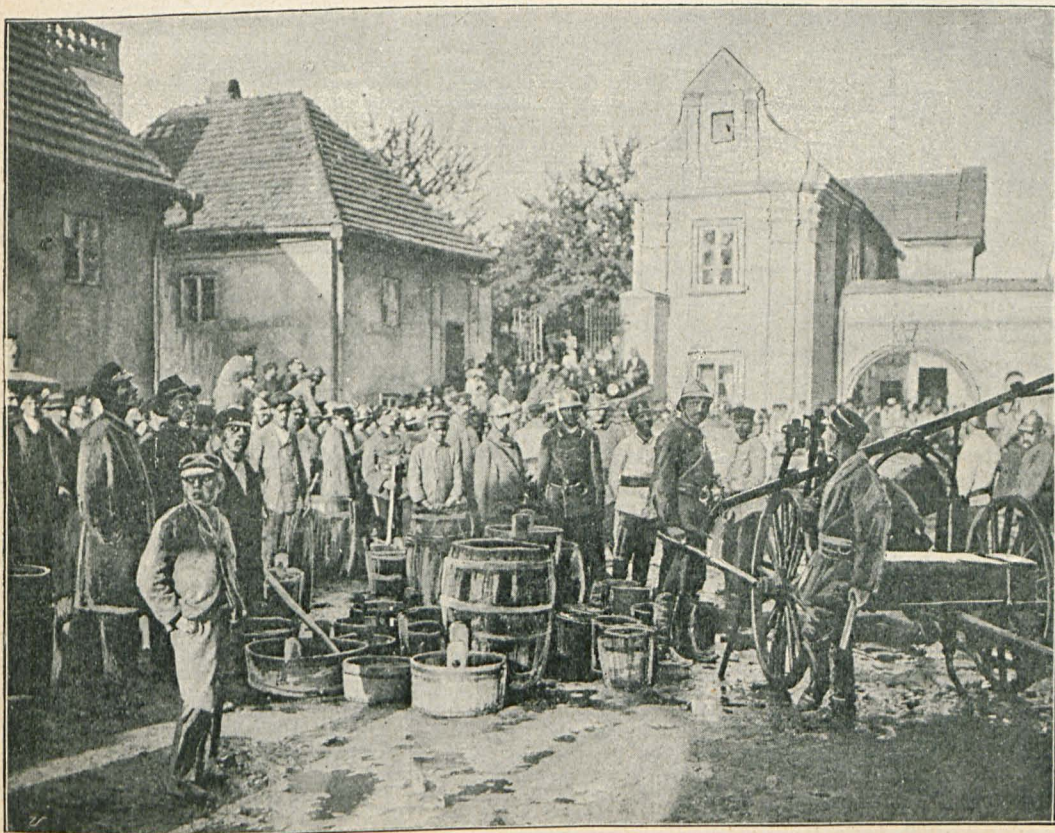
Widok dziedzińca przy wieży nad ranem, po stłumieniu pożaru.
