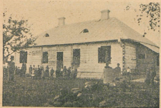
W Łomazach już mają własny budynek szkolny. Obecnie przystępują do budowy mieszkań dla nauczycielstwa.
