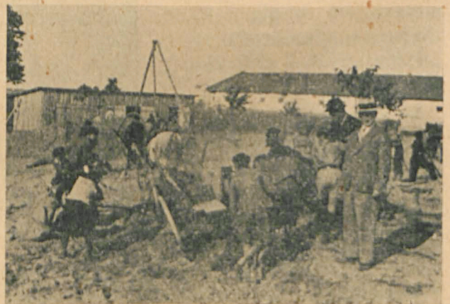
Młodzież szkolna pracuje przy budowie szkoły-pomnika w Białej Podl.
