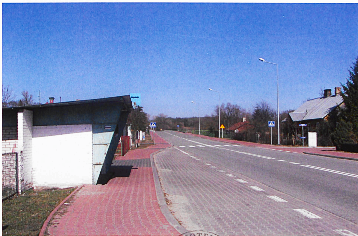
Nowa jakość w Neplach – zniknęły stare słupy energetyczne, zastąpiły je proste i ekonomiczne latarnie.
