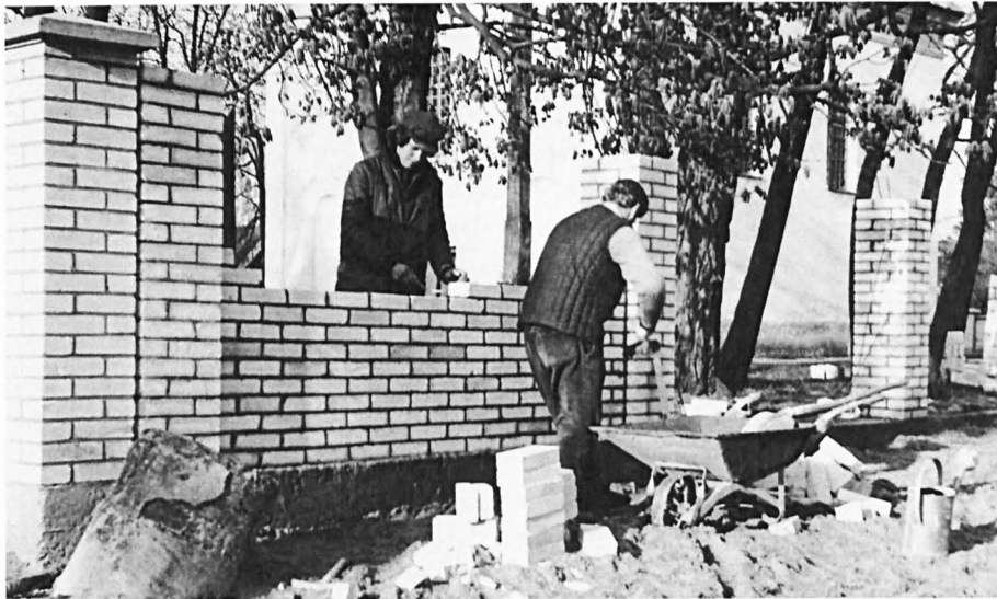
Budowa nowego ogrodzenia z cegły - wiosna 1974 r.
