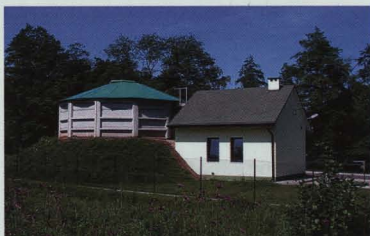
Gmina Nowy Wiśnicz, oczyszczalnia ścieków 135 m 3 /d
