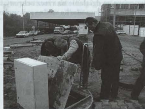
Tak wyglądało przejście w Terespolu w trakcie remontu, na pierwszym planie nowa przepompownia ścieków. Nie trzeba już kilka razy w ciągu dnia opróżniać szamba
