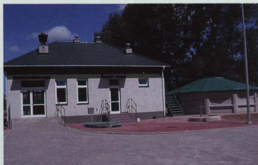
Gmina Rokittno, oczyszczalnia ścieków 90 m 3 /d
