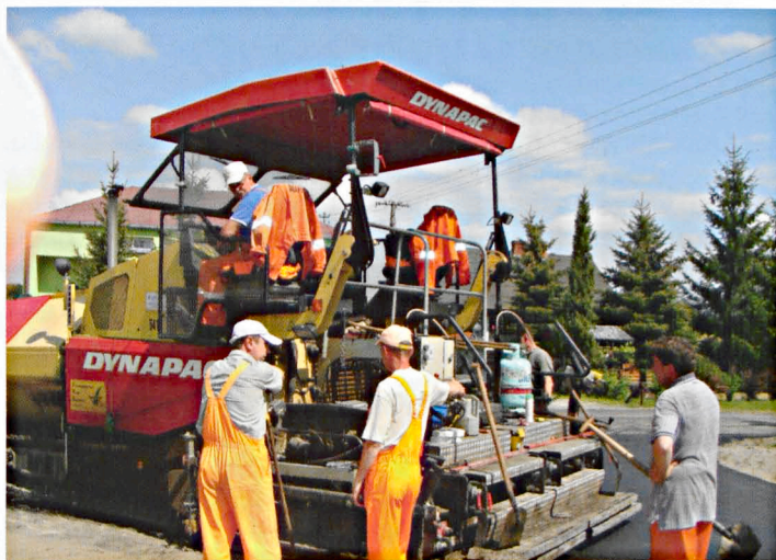
W ciągu trzech lat nowe nawierzchnie otrzymało 13 sołectw
