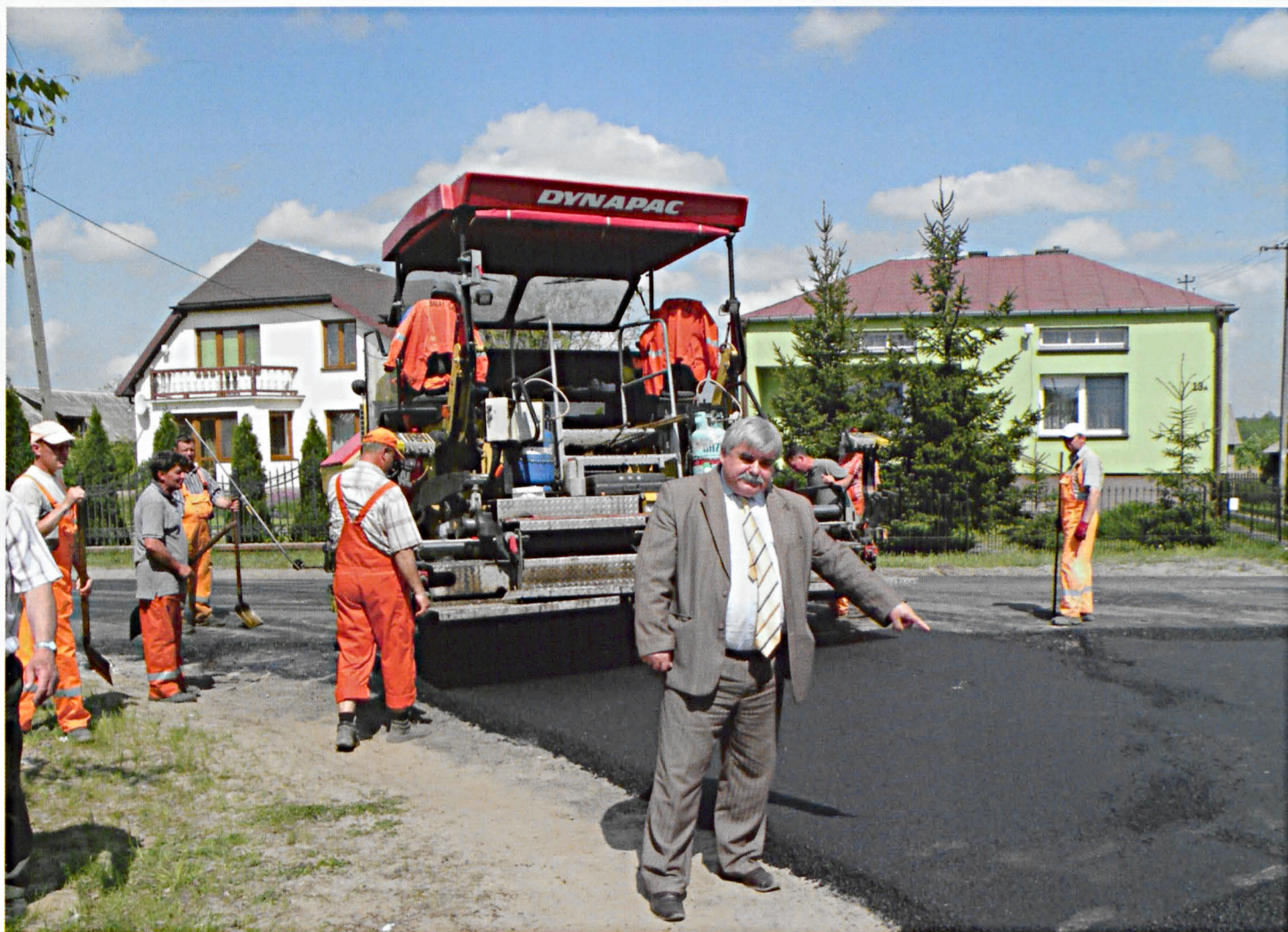
Wójt nadzorował remont nawierzchni drogi w Czosnówce
