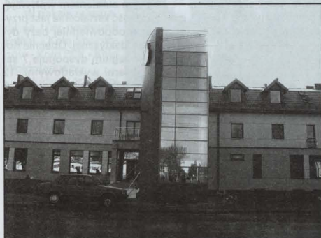
Na oddanie tego budynku do eksploatacji czekają zarówno pracownicy jak i studenci
