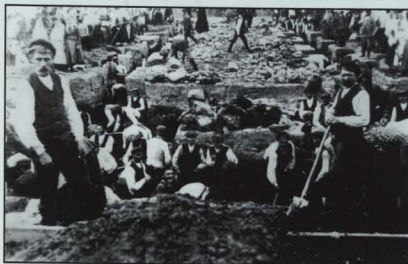
▲ Rozpoczęcie budowy kościoła (1905)
