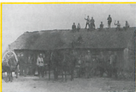
Strażacy rozbierają starą remizę parczewską (zdjęcie z okresu przedwojennego).
