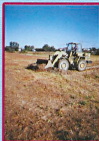
Rozpoczęcie prac przy budowie świątyni
