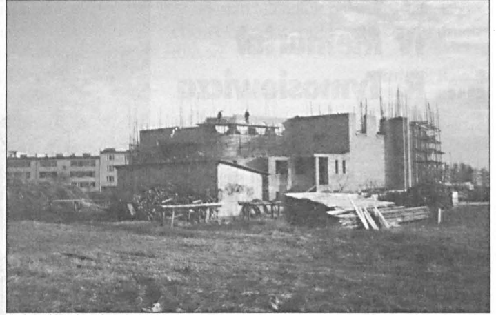
Budowa kościoła – kwiecień 2003
