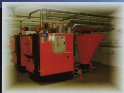
Kotłownia na pelett's ogrzewająca Zespół Szkół w Warszawie
