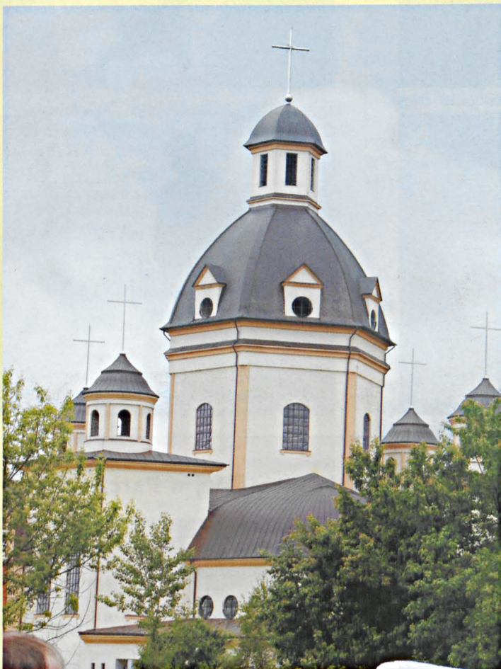
Kopuły budowanego Kościoła Parafii Opatrzności Bożej w Parczewie
