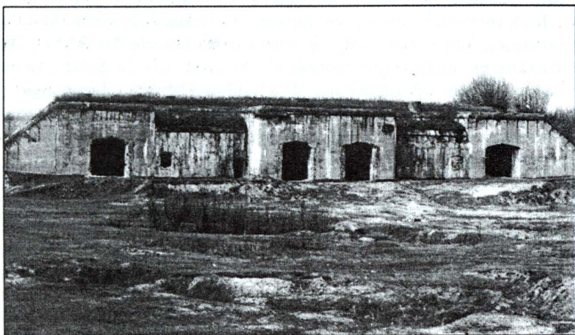
Forty obronne Twierdzy Brzeskiej w rejonie Kobylan. Fot. ok. 1970 r.
