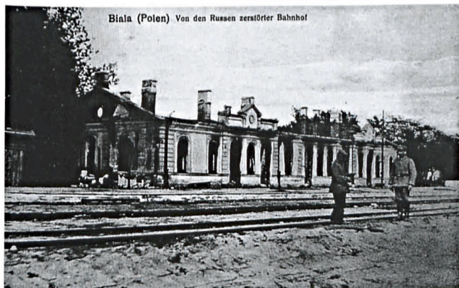
Biała Podlaska, zniszczony dworzec kolejowy I wojna światowa
