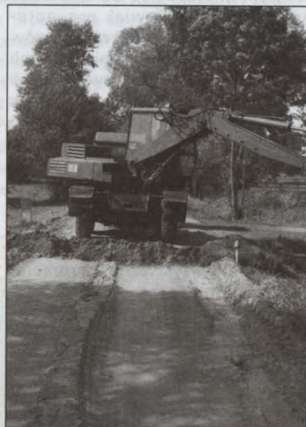
Budowa drogi gminnej w Podedwórze
