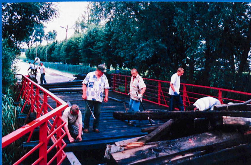
Remont mostu przy ul. Siedleckiej
