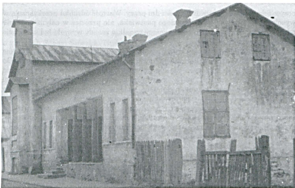
Budynek szkolny w Międzyrzecu na ul. Łukowskiej 11
