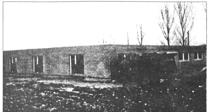
Budowa szkoły w Tłuściecu
