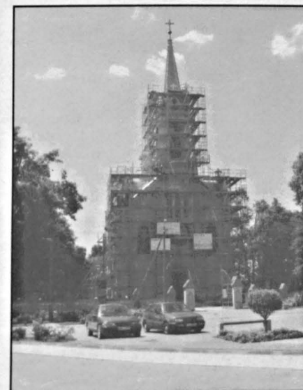
81. Rozpoczęty remont kościoła
