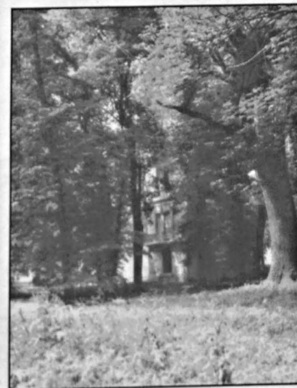
94. Pozostałości wieży ciśnień w parku
